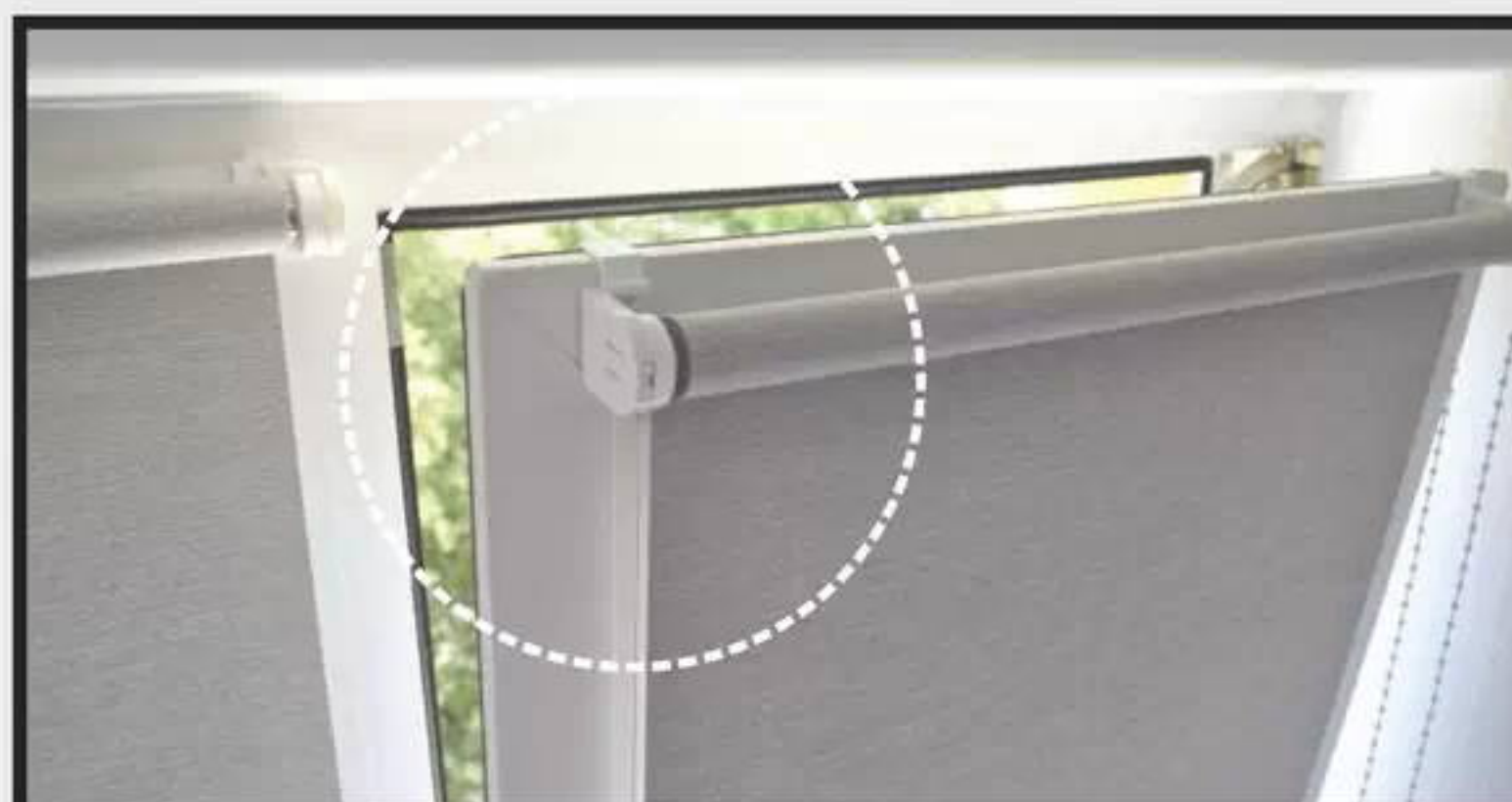
вариант верхнего крепления
